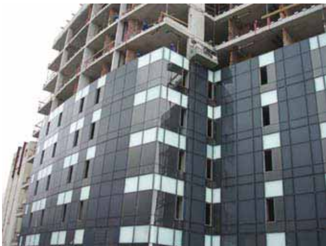
Mandela Rhodes Projekt Südafrika: Fixarea unei fatade pe cadre cu ajutorul clamerol HCW-B2 de sinele de ancorare HTA
