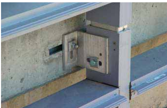
Fixarea unei fatade pe cadre cu ajutorul clamelor HCW-ED de sinele de ancorare HTA
