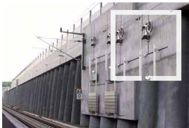
Constructie de tuneluri: Fixarea dispozitivelor de sustinere a firelor electrice
