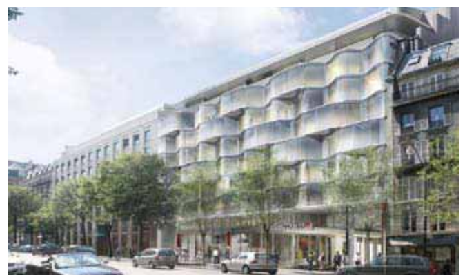
Fixarea fatadelor de sticla cu sine HALFEN Hotel Renaissance, Paris
