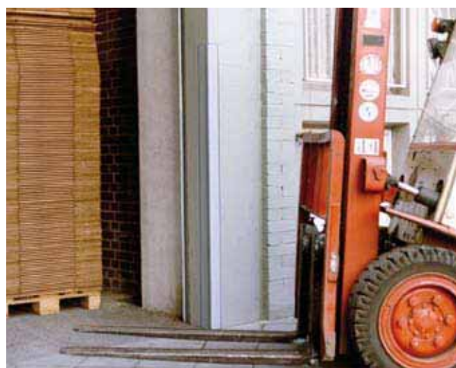
Exemplu: protectii de muchii la pereti si stalpi intr-o hala industriala
