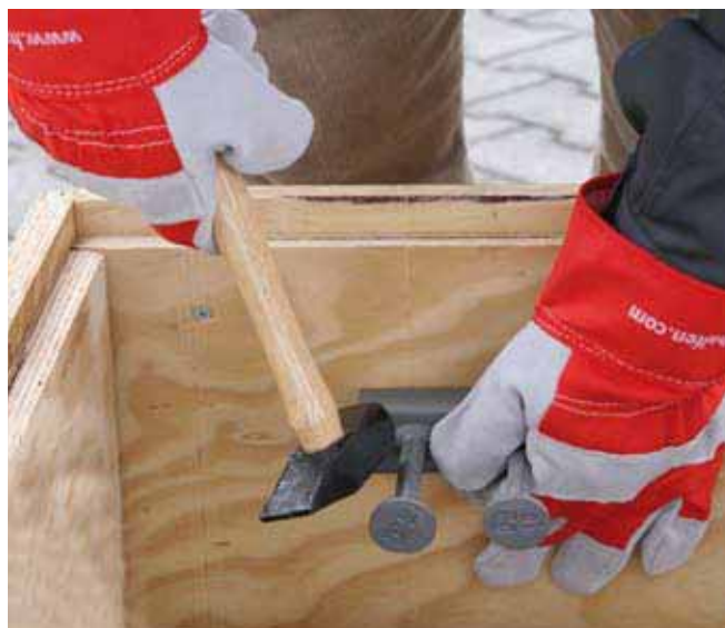
Prindere cu cuie a sinelor HALFEN de cofraj
