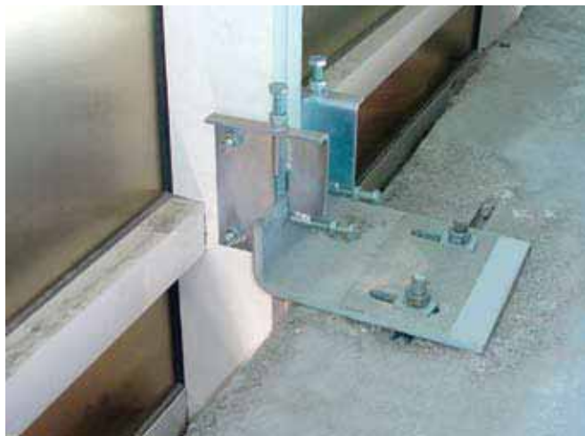
Liberty Life Projekt Africa de Sud: Fixarea peretilor cortina cu ajutorul clamelor HCW-B2 de sinele de ancorare HTA
