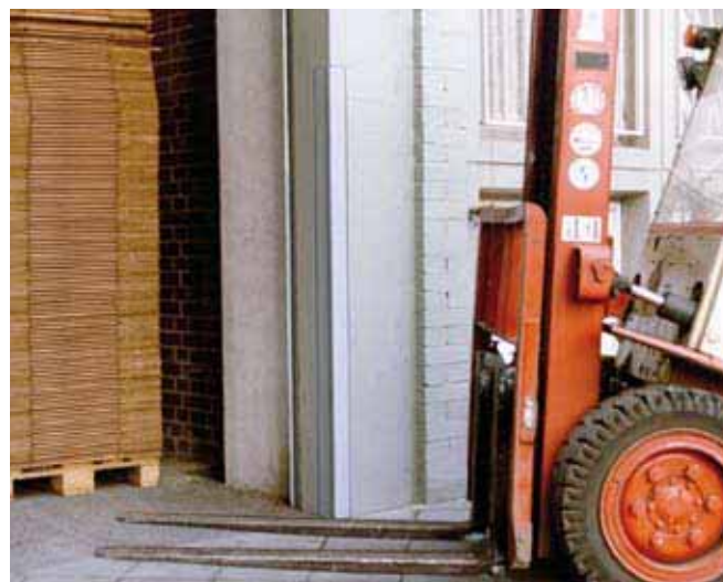
Exemplu: protectii de muchii la pereti si stalpi intr-o hala industrială
