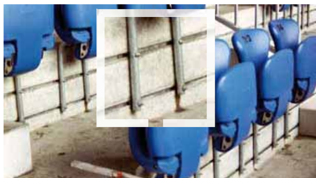
Fixarea scaunelor pe stadioane: Fixarea pe randuri
